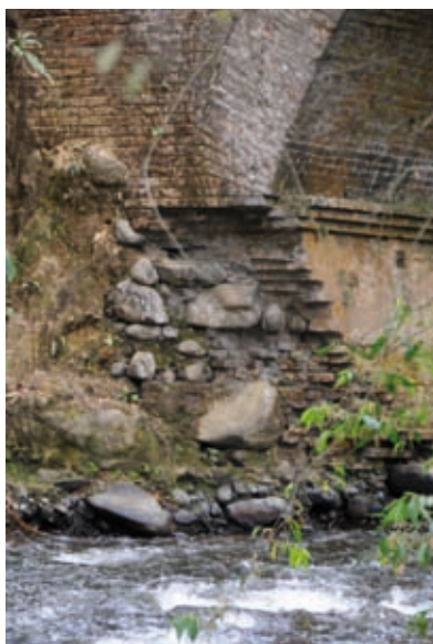
Puente sobre el Rio El Cofre
