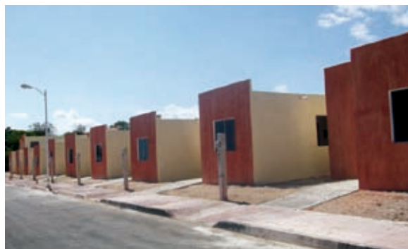
Figura 4 Viviendas con diseño poco apropiado.
