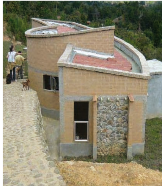
Imagen 18. Vivienda con bloques de tierra comprimida elaborados con una máquina cimva ram. Foto: Arq. Carlos Mauricio Bedoya.
