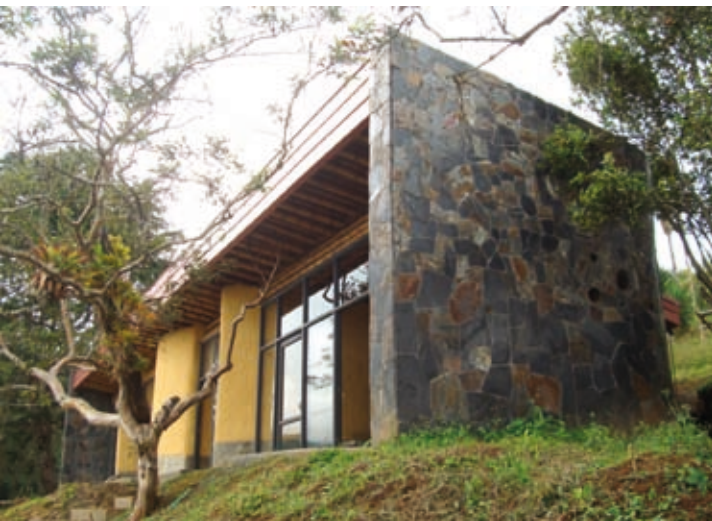
Imagen 19. Vivienda en El Carmen (Dagua). Foto: Arq. Julián Gutiérrez.
