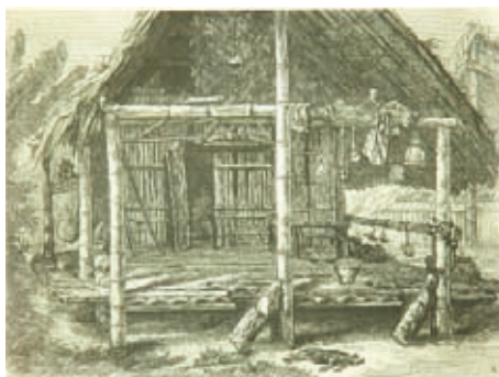
Imagen 3. Vivienda en Agua Blanca. Edouard André (1875-1876). Fuente: (André, 1879)
